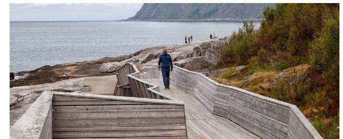
Figur 32. Utsiktsplats och fantasifullt utformad ramp och "brygga" i trä, från en av rastplatserna i Norge. Bild från Visit Norway.
